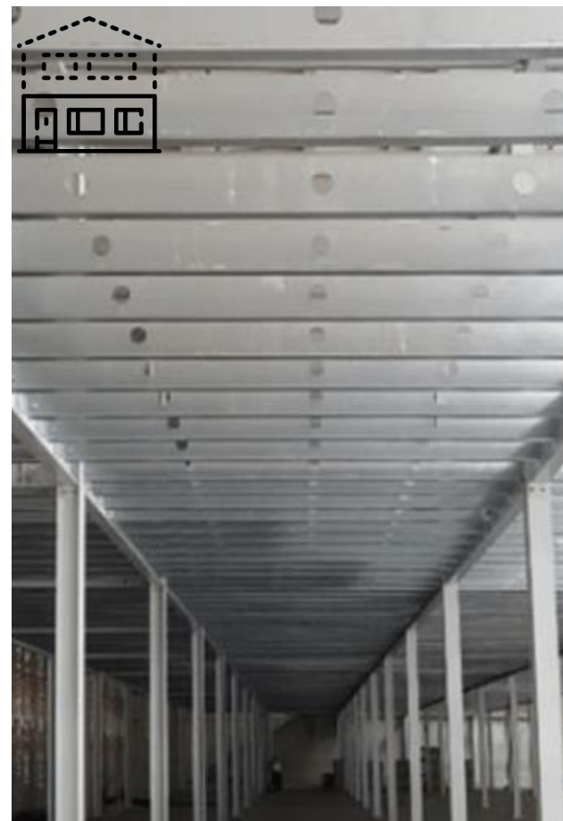
Entreplantas: readaptación de espacios diáfanos de gran altura a las necesidades del cliente.
